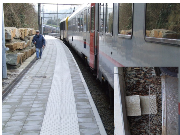
Accostage de l'IC33 en gare de Rivage (quai en courbe) La lacune horizontale atteint 50 cm !
