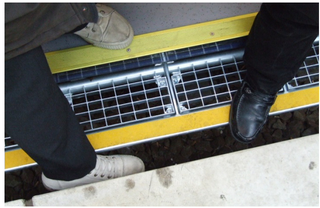
Devant un quai haut, le marchepied (situé en contrebas) ne comble pas la lacune (de 30 cm) entre la voiture et le quai
